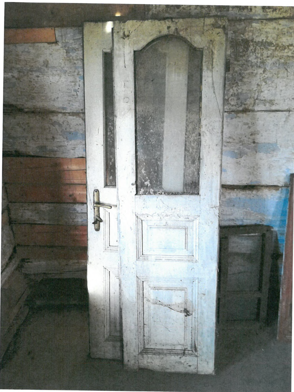
il. 17. Drzwi w izbie południowej w ścianie działowej. 2019. Fot. MMK
