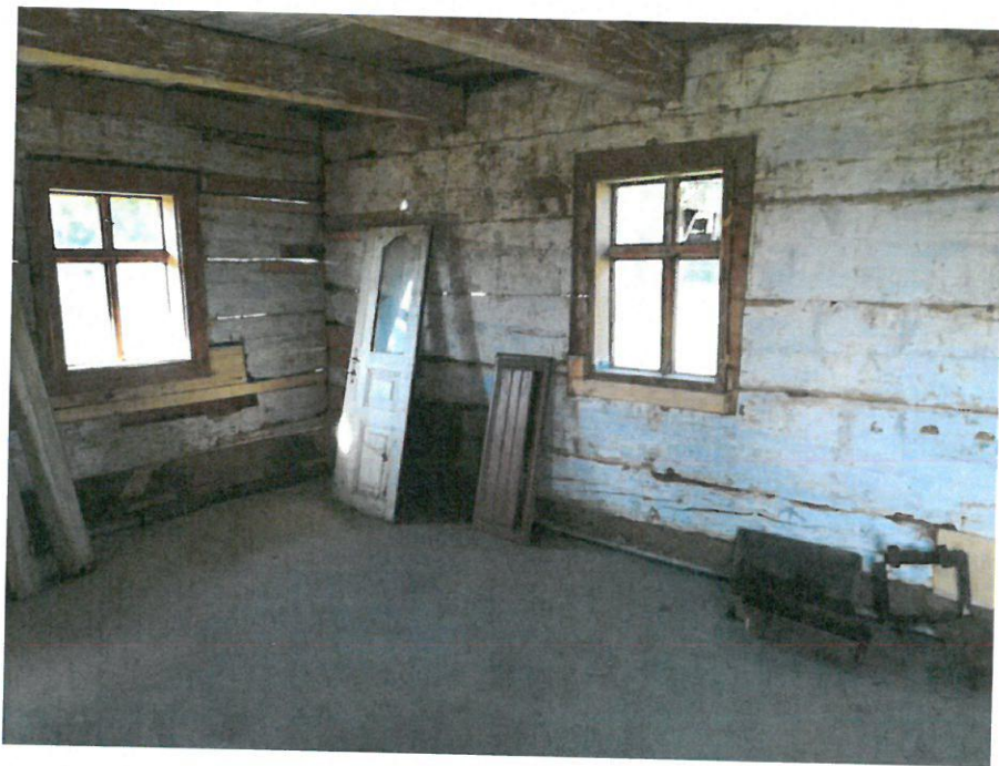
il. 22. Okna w izbie południowej od wnętrza. 2019. Fot. MMK
