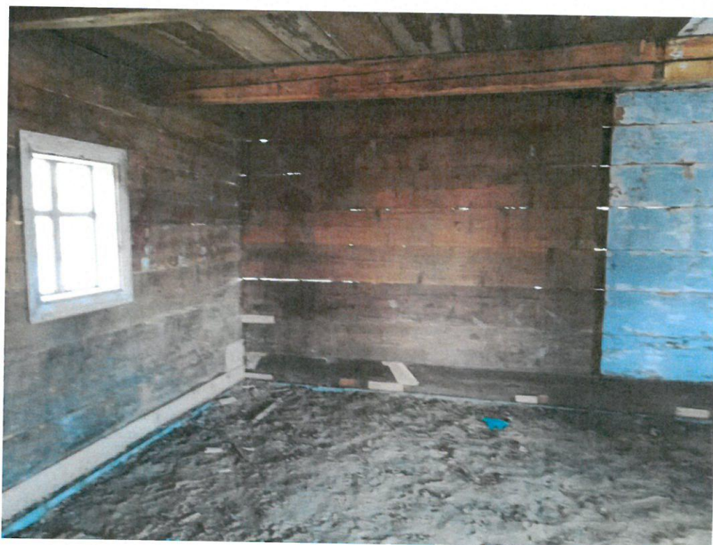
il. 11. Wnętrze izby północnej, widać ślady po ścianach działowych. 2019. Fot. MMK
