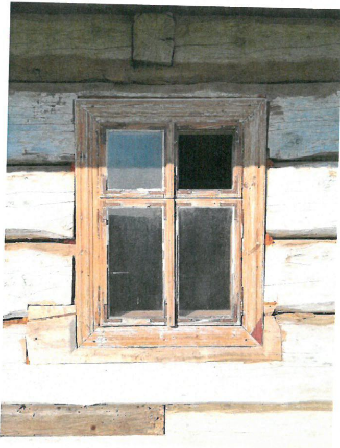
il. 21. Okno w ścianie południowej. 2019. Fot. MMK
