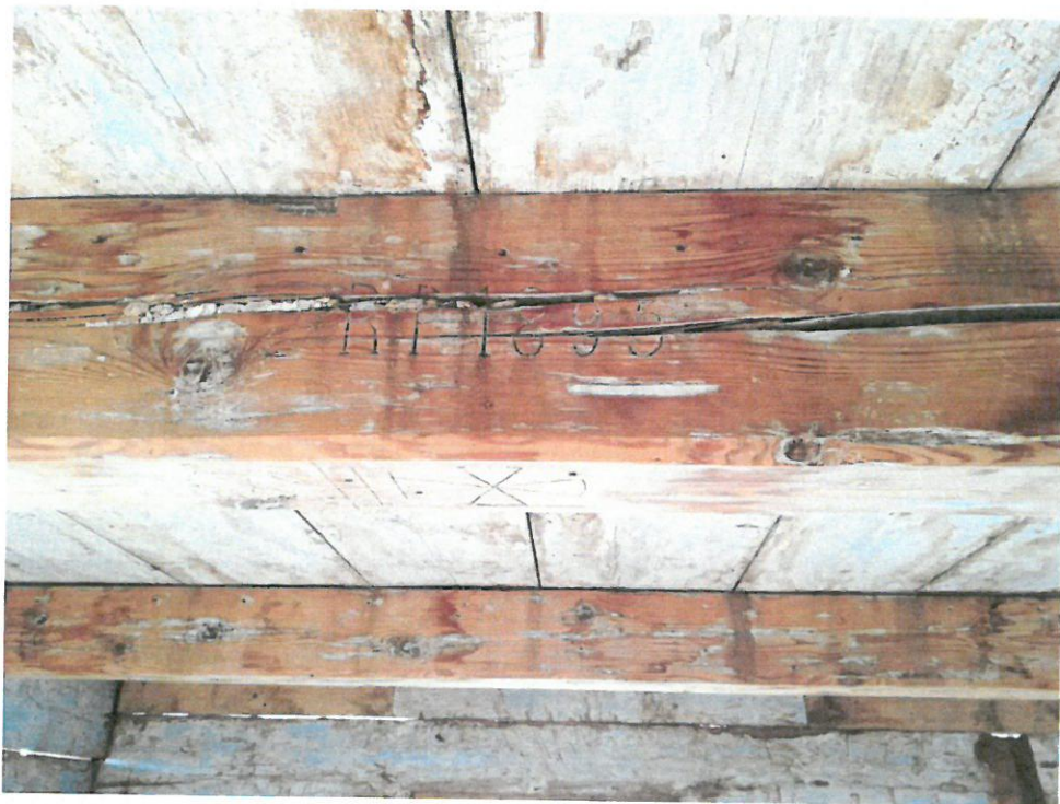
il. 12. Data na tragarzu w izbie południowej. 2019. Fot. MMK
