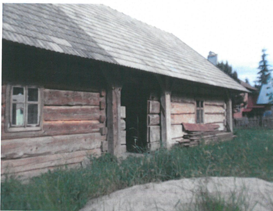
Fotografia 7: Ściana zewnętrzna od zachodu
