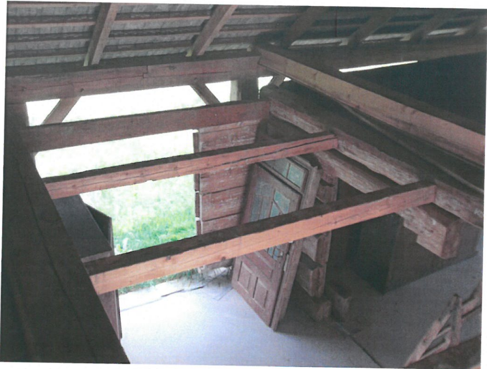
Fotografia 8: Strop nad sienią
