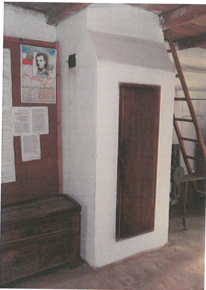
Fotografia 1: Część komina w sieni z lodówką o wymiarach 60x90cm
